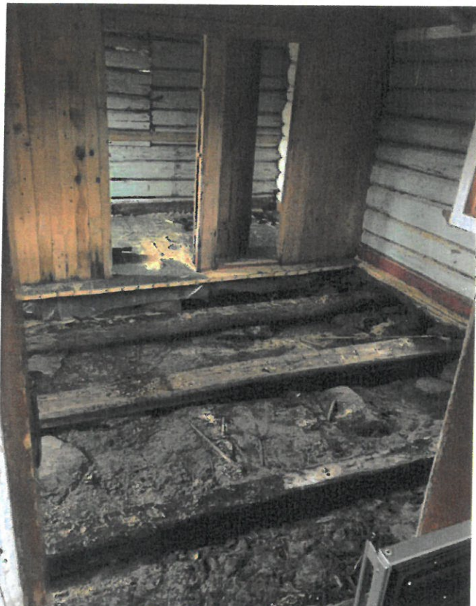
BILDE 1: Innvendig golvkonstruksjon
