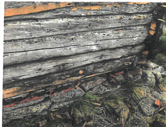
BILDE 2/3: Utvendig bunnstokk / svill / grunnmur
